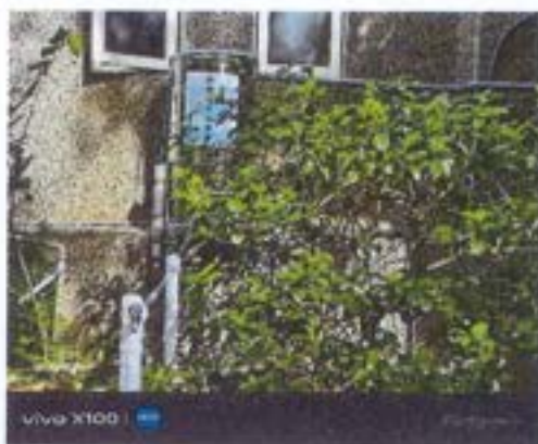
說明：標示 64 目雨水過濾器
