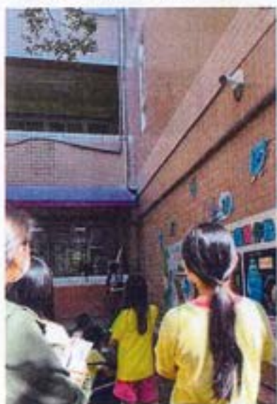
說明：由頂樓收集雨水再利用
