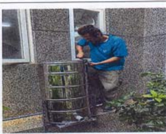
說明：施工人員安裝雨水過濾器
