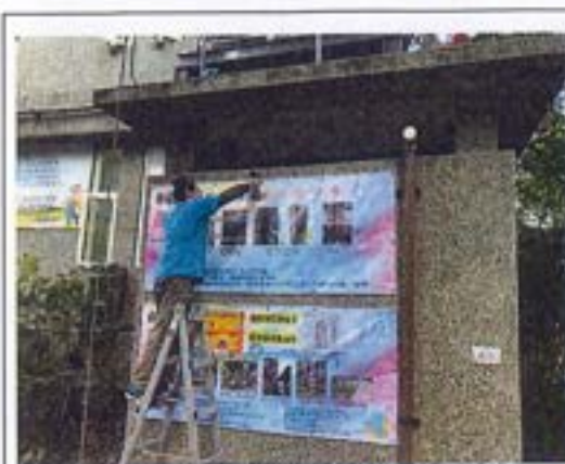
說明：施工人員安裝宣導海報
